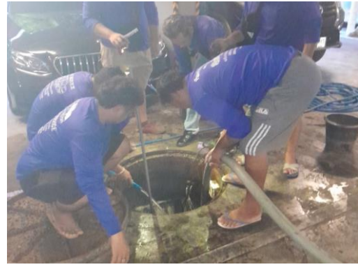
สูบน้ำตะกอนส่วนเกิน
