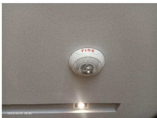
อุปกรณ์ส่งสัญญาณเตือนเพลิงไหม้ (Flashing Light)
