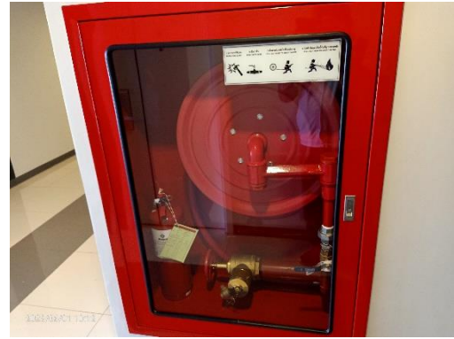
ตู้เก็บสายฉีดน้ำดับเพลิง (Fire Hose Cabinet)
